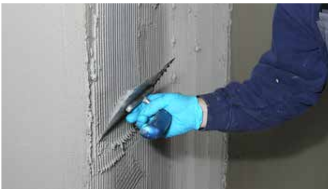
Unutarnja hidroizolacija podruma
