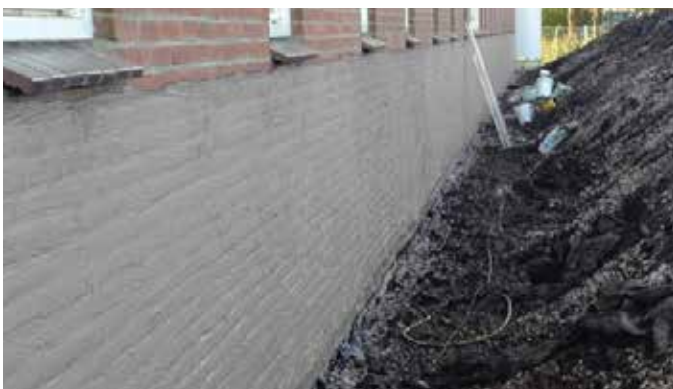
Vanjska hidroizolacija podruma
