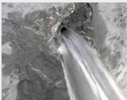
Aktivno curenje se zatvara odmah nakon nanošenja KÖSTER KD 2 Blitz praha.
