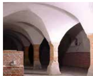
Unutarnji zidovi ovih zgrada restaurirani su KÖSTER Sanacijskom žbukom bijelom.
