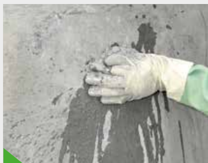
Aktivno curenje se zatvara odmah nakon nanošenja KÖSTER KD 2 Blitz praha.
