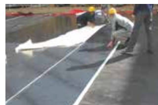
Hidroizolacija s KÖSTER KSK
