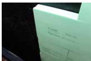
Izolacijske ploče se mogu jednostavno pričvrstiti dvokomponentnim KÖSTER PMBC-ima. Važno je da su izolacijske ploče potpuno zalijepljene.
