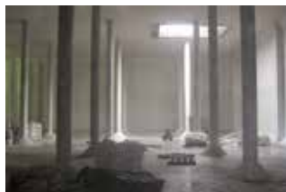
Pozitivna hidroizolacija spremnika sa KÖSTER NB 1 Sivi
