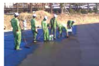
Hidroizolacija s KÖSTER Deuxan 2C
